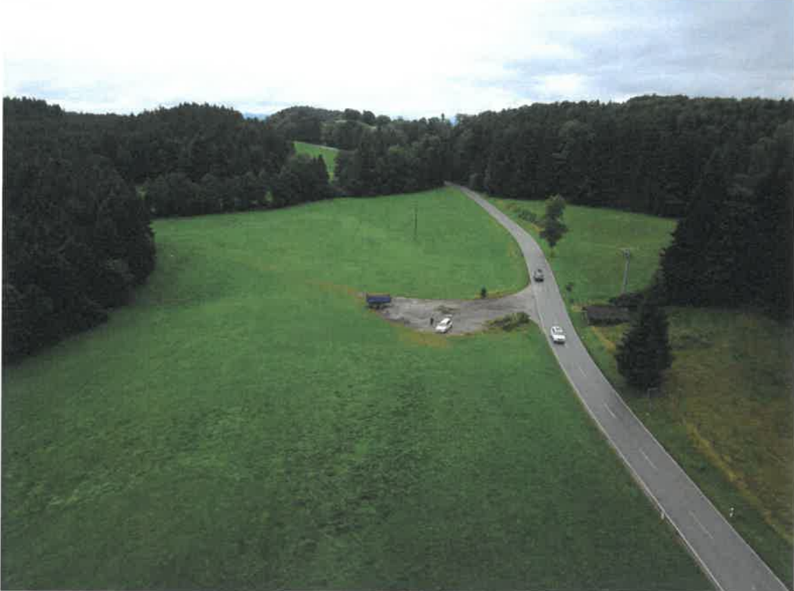
Abbildung 4: bestehende Nutzung geplanter Geltungsbereich (Blickrichtung Osten), 2019, Foto: VISPIRON EPC GmbH, München
